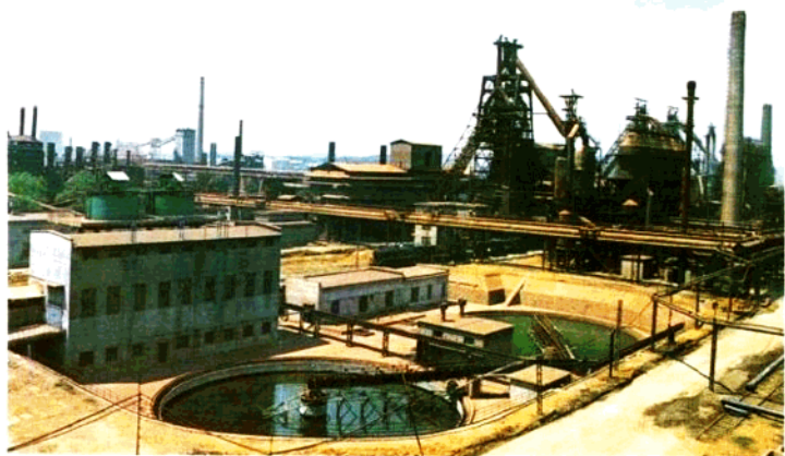
广西柳州钢铁厂炼铁高炉一角。
