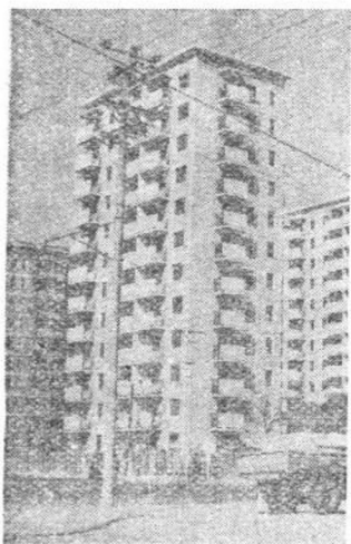
图 1-1 北京建造的大板建筑外形
