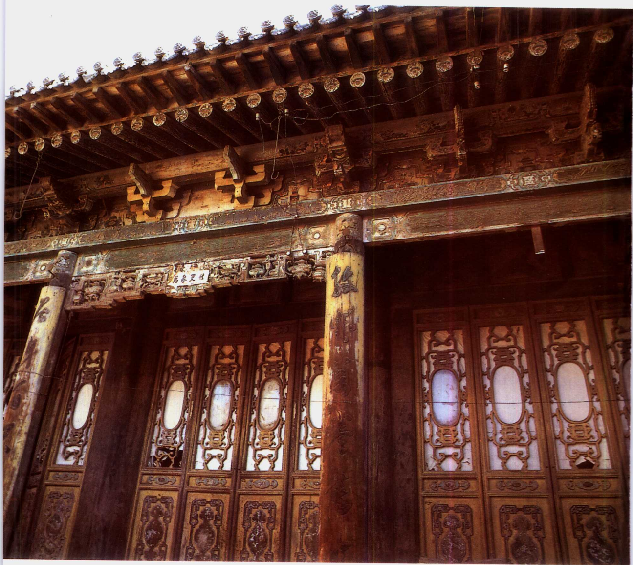
图2 山西太谷县上观巷一号正房
