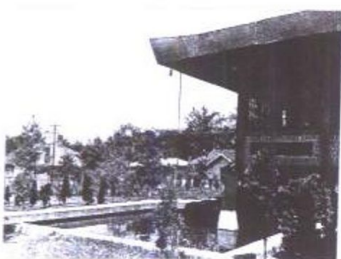
进行传统与现代相结合尝试的建筑
