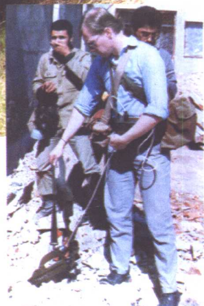
对废弃生产设施进行检测
