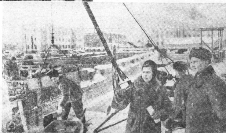
上：西伯利亞額爾齊斯河上建築的強大水電站。在極惡劣的氣候下，利用層板暖棚，繼續不斷地進行施工。
