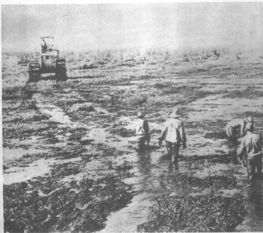
这是古巴土改后一組农业工人在沼澤地里插桩，准备修建堤壩，改沼澤地为良田。
