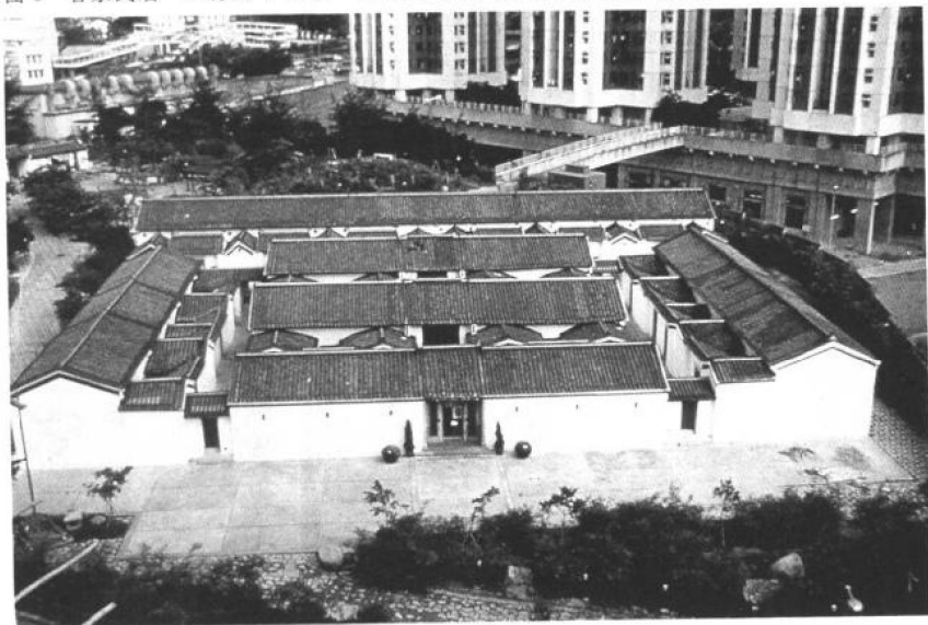
图 6 客家民居“三栋屋”，1757~1786 年建成（古物古迹办事处提供）
