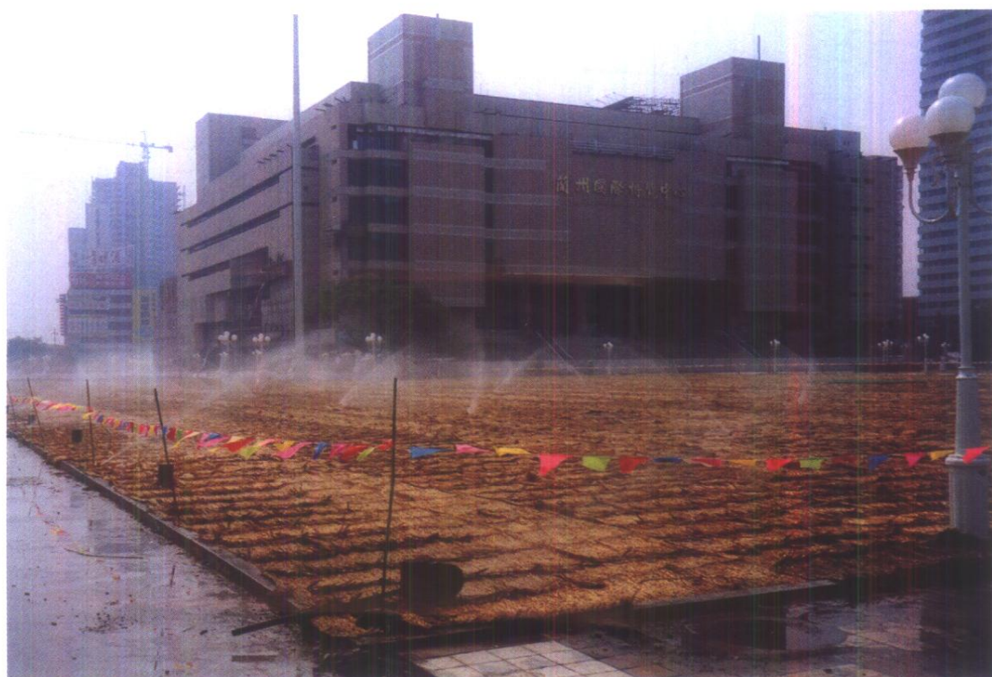
草坪播种后覆盖、喷水(兰州市东方红广场绿化美化工程)
