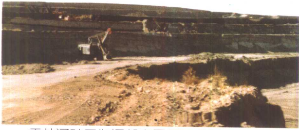
霍林河矿区指挥部南露天矿采场
