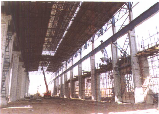
准格尔煤田在建设中
