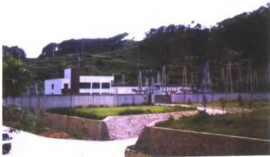
110KV明珠电站
