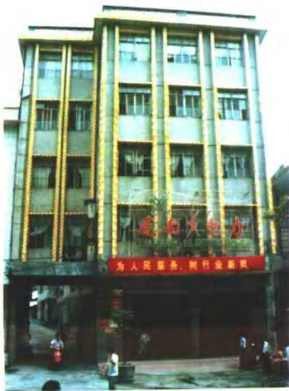
县供电局办公大楼
