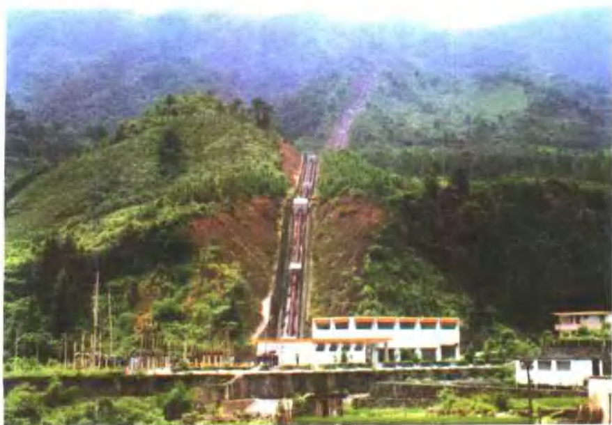
板洞水库一级电站
