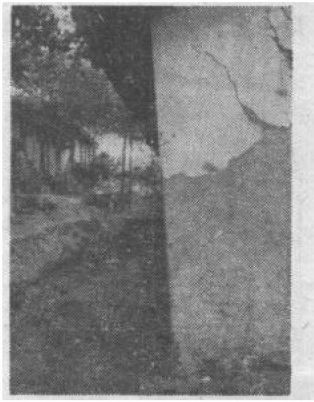
照片2 住宅倾斜（白细线为垂直吊线）
