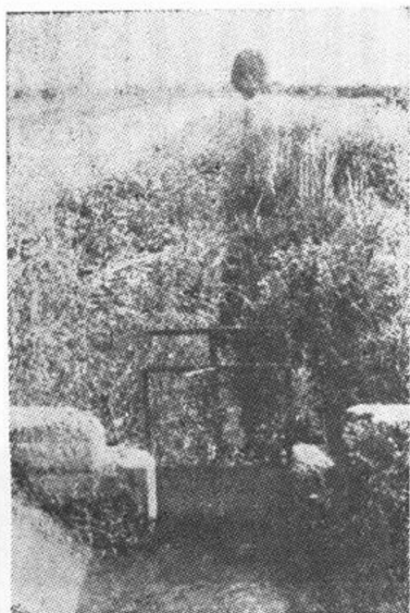
图 1 杂草蔓延的灌水沟，实测每公里渠长腾发量的损失达流量的20%
