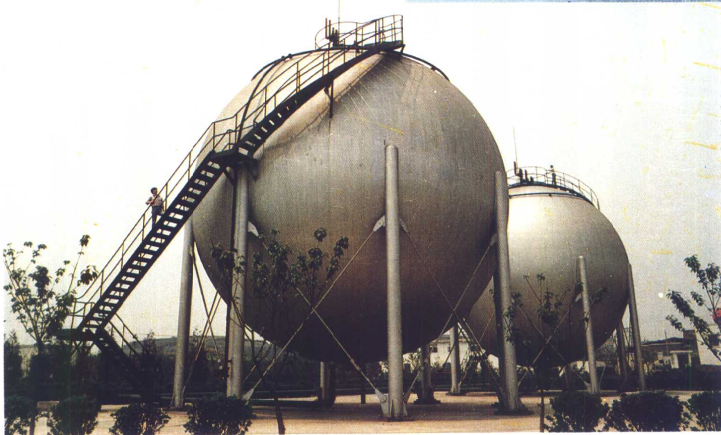
重钢生产的 16MnR 钢板及用其制造的大 型球罐
