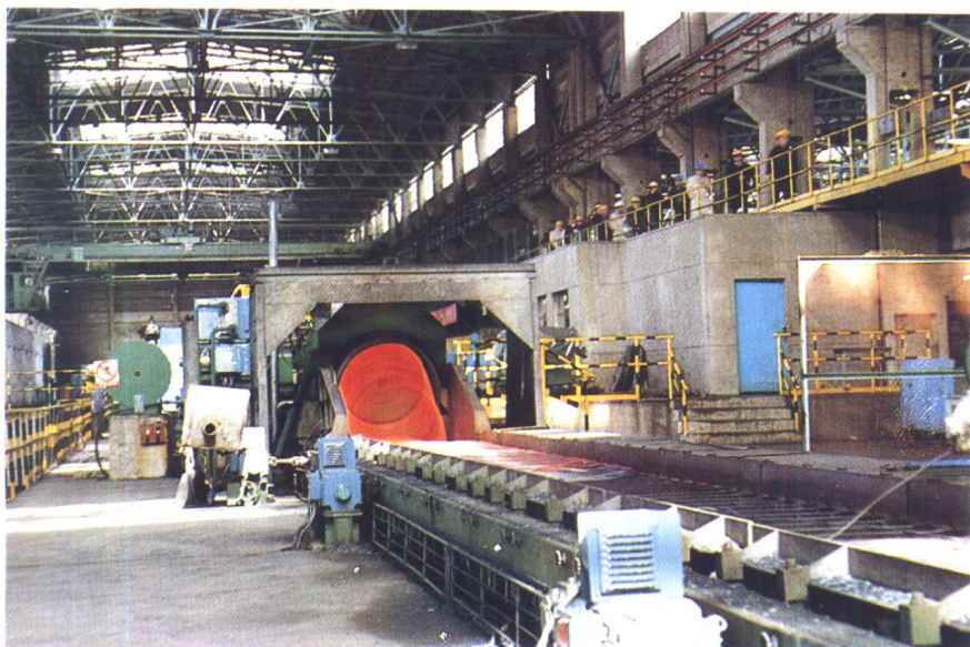
酒泉钢铁公司的高速线材轧机的冷却系统
