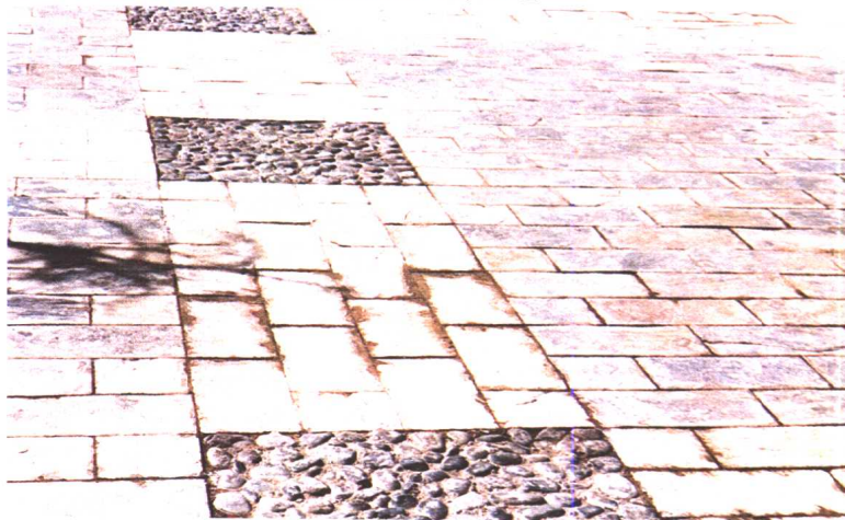
架空平台上以天然石板铺砌的人行步道
