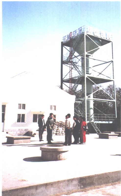
北潞春小区中水站
