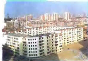
“宣兴”正在开发建设的旧宫住宅小区
