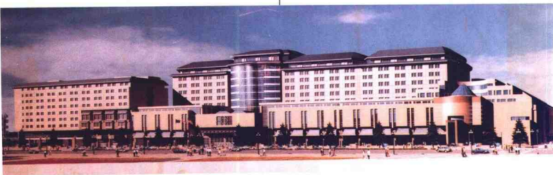
位于北京西客站前的京门大厦外观概览
