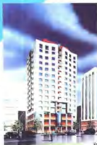
“宣兴”正在建设中的宣兴大厦
