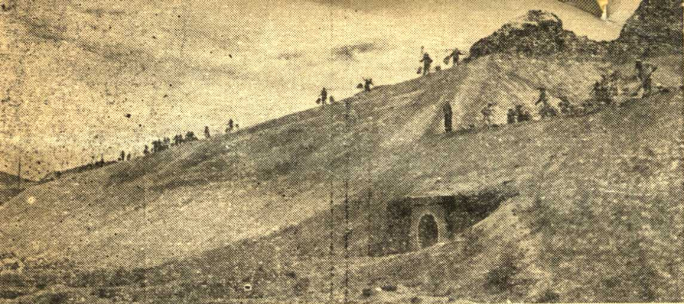
上：蘭新鐵路進行路基填土工 程。
