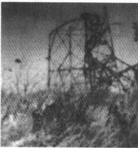
图 1-1 500kV 线路 覆冰引起塔头倒塌
