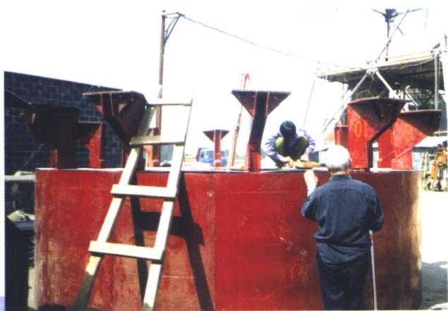
梁北矿东风井液压滑模套壁装置地面预组装
