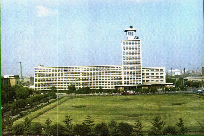
沈阳电信大楼
