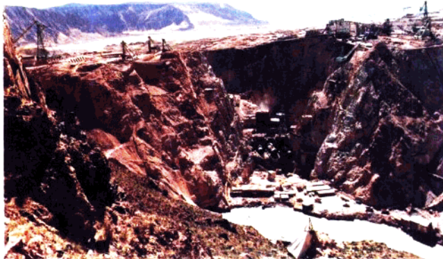
正在施工中的 龙羊峡水电站
