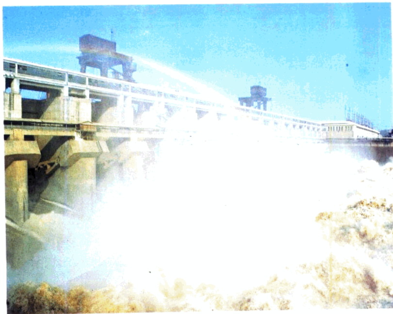
葛洲坝工程泄洪闸
