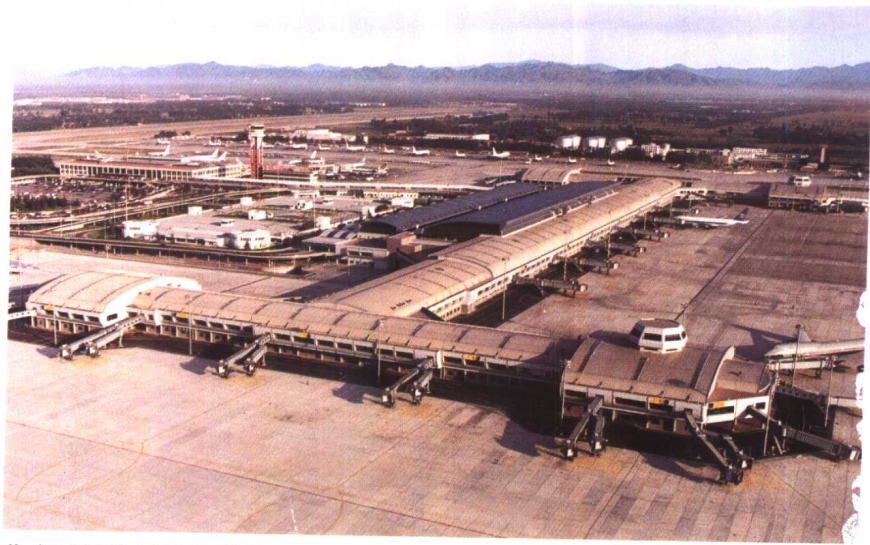
北京城建集团承建的首都国际机场新航站楼
