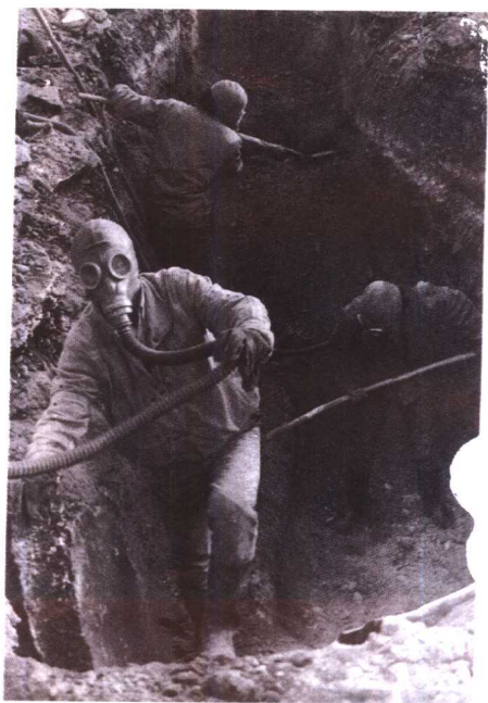
抢险大队队员们冒着生命危险排除煤气泄漏险情
