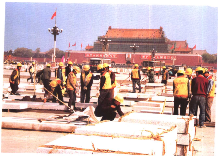
北京城建集团承建的天安门综合市政改造工程
