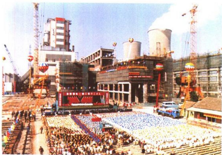
国家重点工程——蒲城电厂二期工程开工
