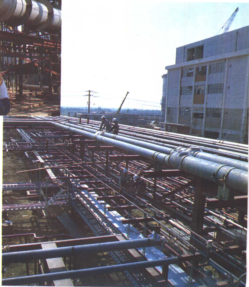
▲ 仪征化纤工业联合公司一厂正在安装设备和管道
