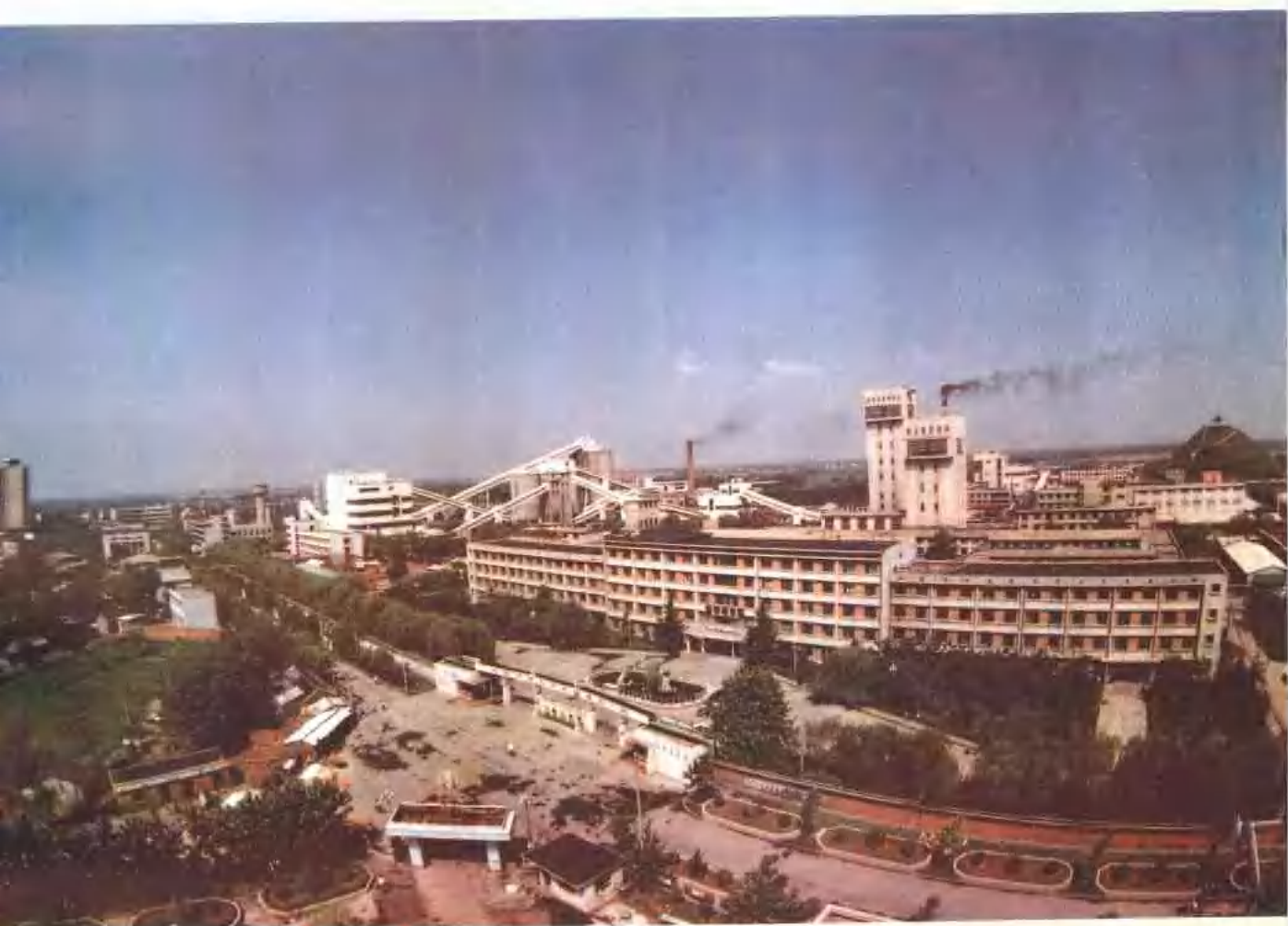
设计年产原煤 300 万吨兴隆庄煤矿
