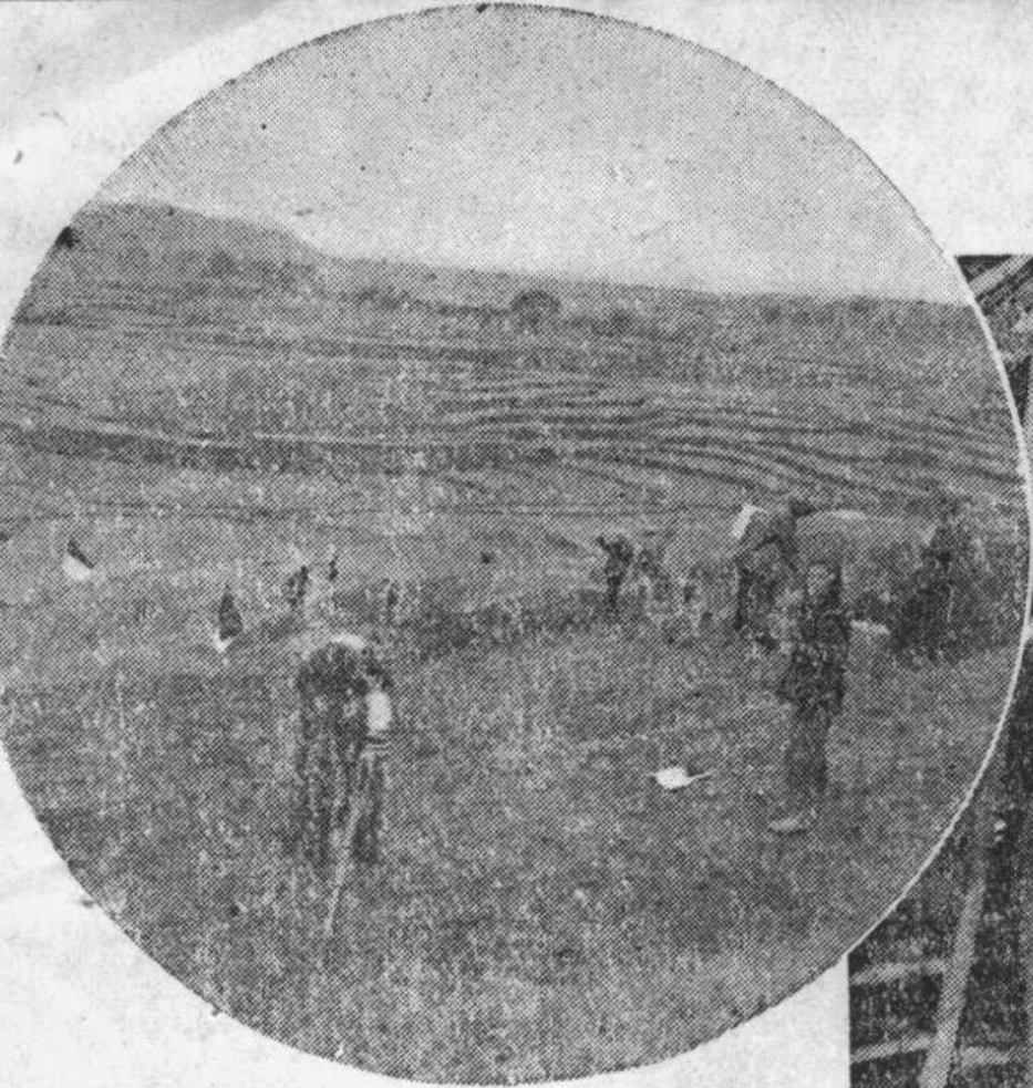
上圖是一個物理探礦隊正在工作。他們用的是磁力法——用一個磁秤實地測量磁性的變化，這樣就可知道磁性礦體的大小。
