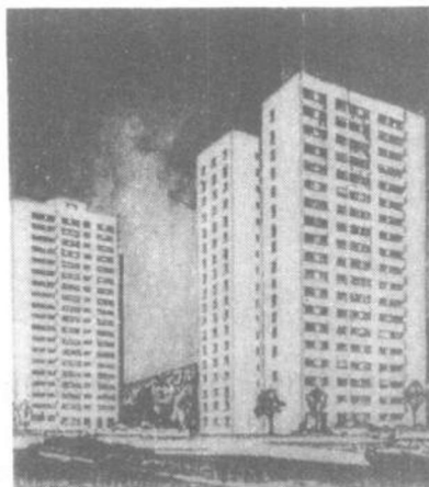
图3 采用砌体承重墙建于瑞士的高层房屋
