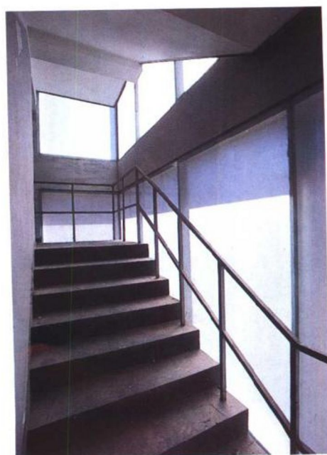
东南楼梯间内
