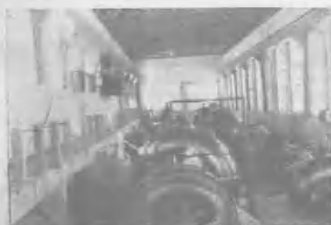
(一八) 田莊合抽水機房
