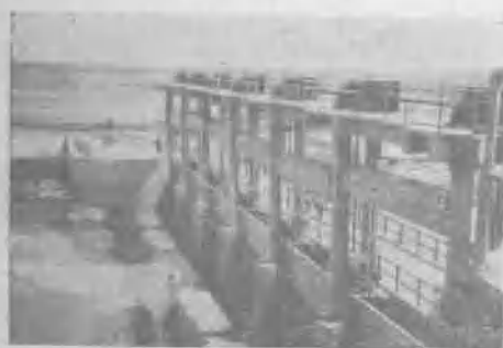
(一三) 屈家店引河泄水閘
