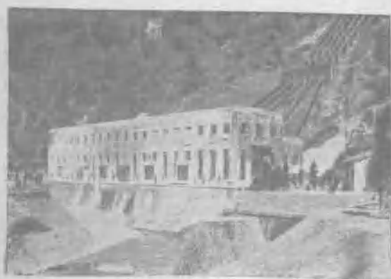
(二) 大觀水力發電廠外觀
