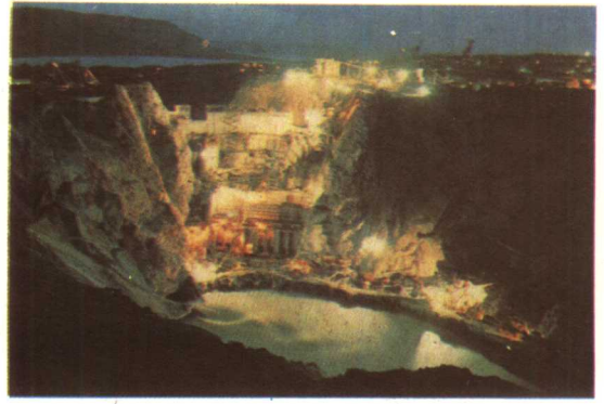
龙羊峡大坝夜景
