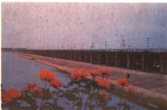
荆江分洪工程闸
