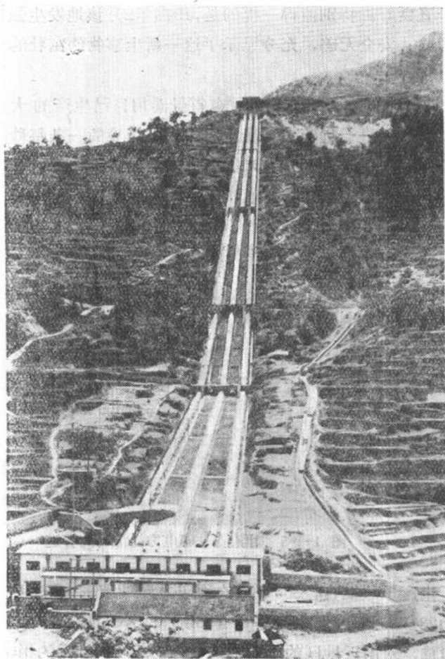
图 1-1-6 广东省罗定水电站进水管道
