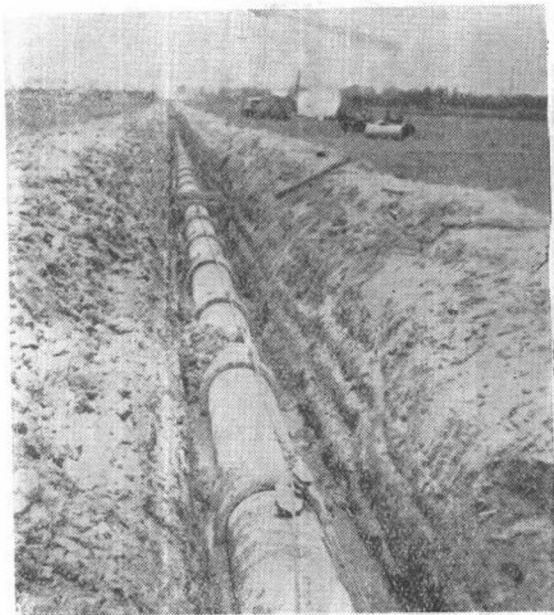
图 1-1-4 营口市某输水管道
