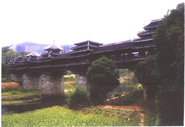
马安寨程阳桥 李新风 摄
