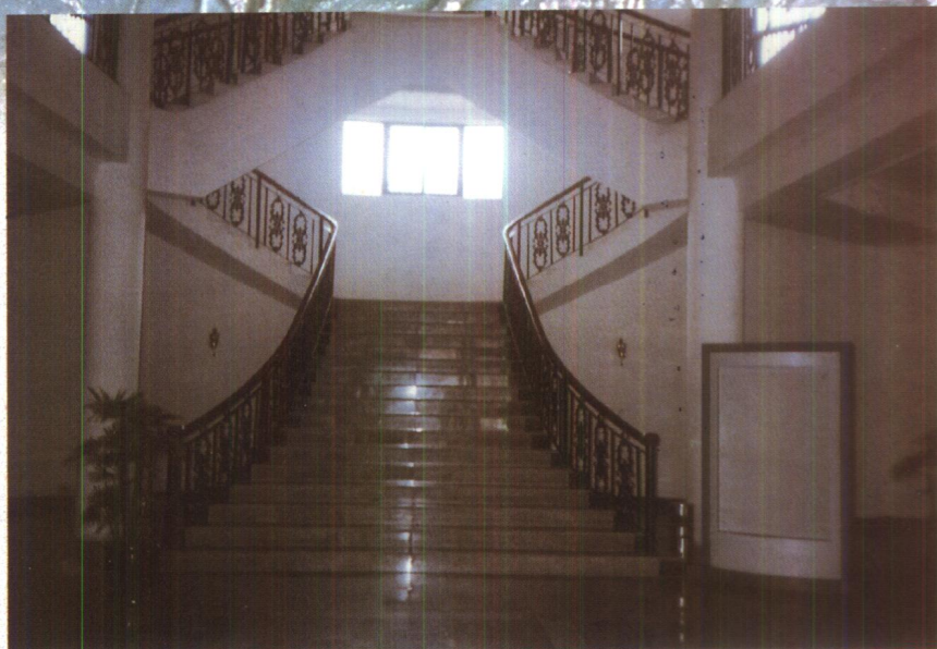
■ 彩图18 喇叭形弧段曲尺双分式上接双连对折交叉式楼梯用于办公大楼进厅（上海浦东新区城管办大楼）
