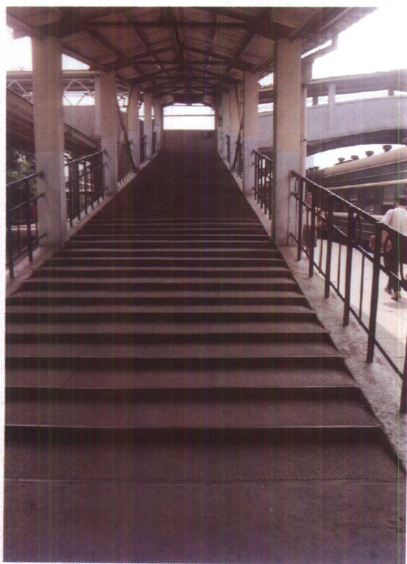
■彩图6 左右直上曲尺双合桥式楼梯用于车站月台（山东烟台火车站）
