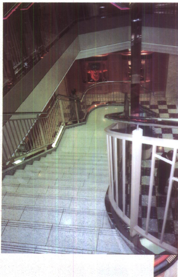
■彩图8 下行二段曲尺式楼梯用于商场竖向交通（日本东京某商场）
