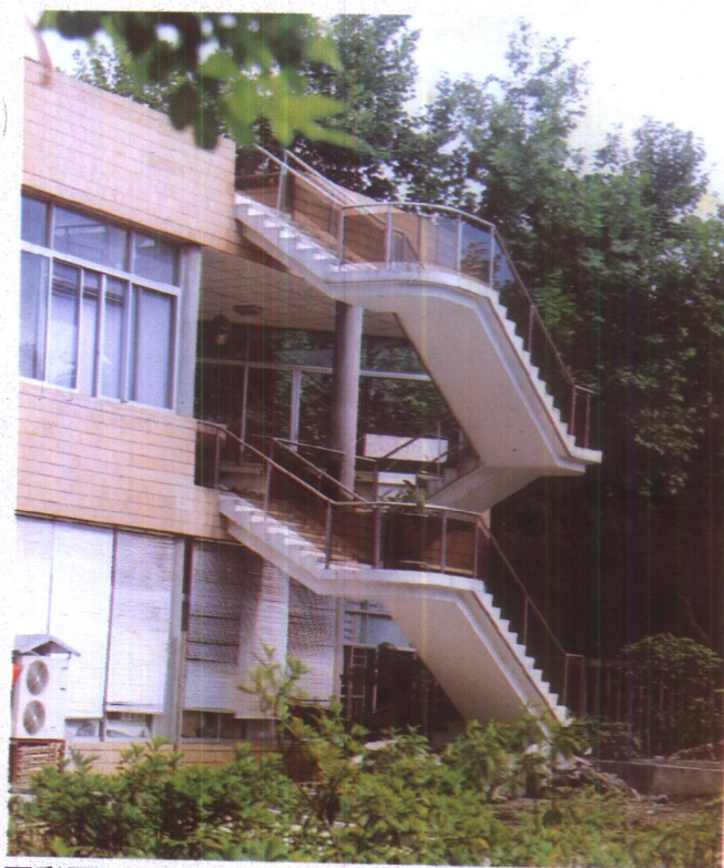
彩图24 凹形剪刀板三折悬挑楼梯用于室外疏散交通 (上海现代音像电器总公司)
