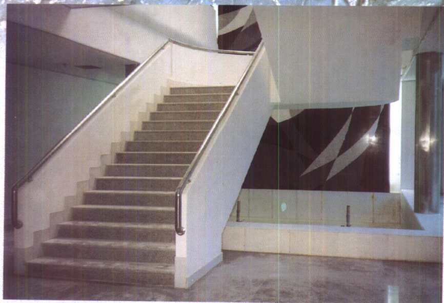
■彩图15 对折式剪刀板悬挑楼梯用于进厅（上海同济大学逸夫楼）
