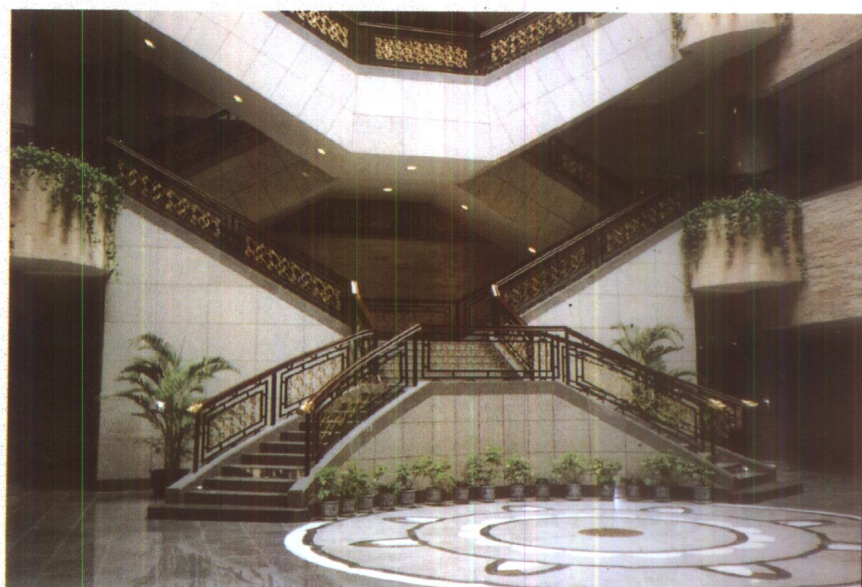
■ 彩图20 八字弧段双合曲尺双分式接双连对折交叉式楼梯用于博览建筑中庭（上海博物馆）
