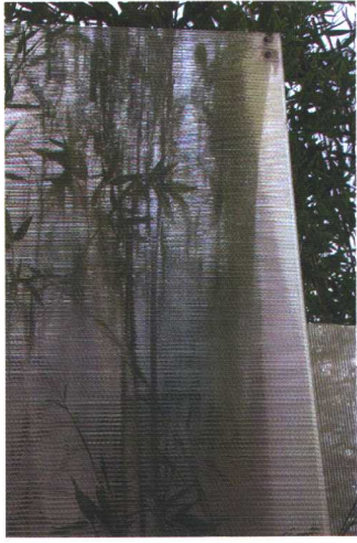
非常建筑： 竹屏风门·细部 (摄影：方振宁)
