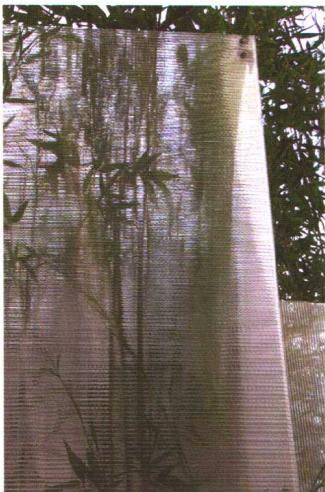
非常建筑： 竹屏风门·细部 (摄影：方振宁)
