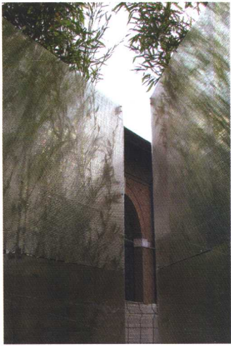
非常建筑：竹屏风门·细部 (摄影：方振宁)
