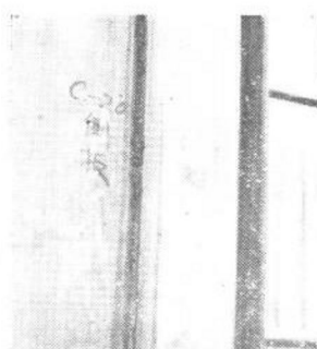
图2 SUS 304L 贮罐圈板 立缝上锈渍堆积情况
