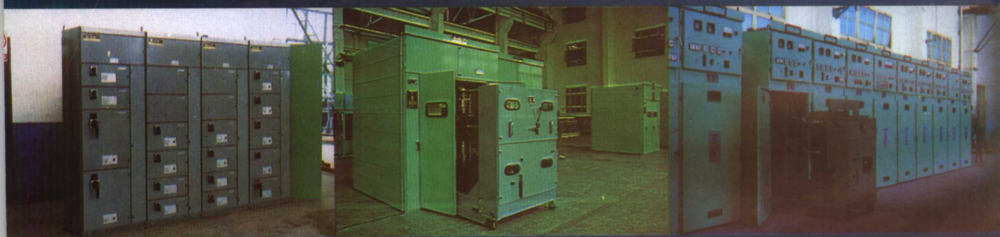
GCK: 低压抽屉式配电装置 GBC-35 高压开关柜(内配35kN真空开关) GC5-10(F)防误型手车式高压开关柜
