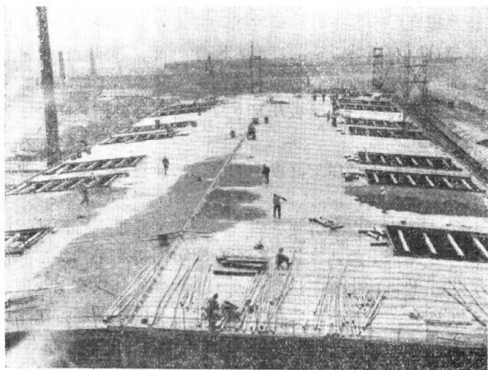
图 1-2 上钢三厂平炉车间天井式天窗施工情况
