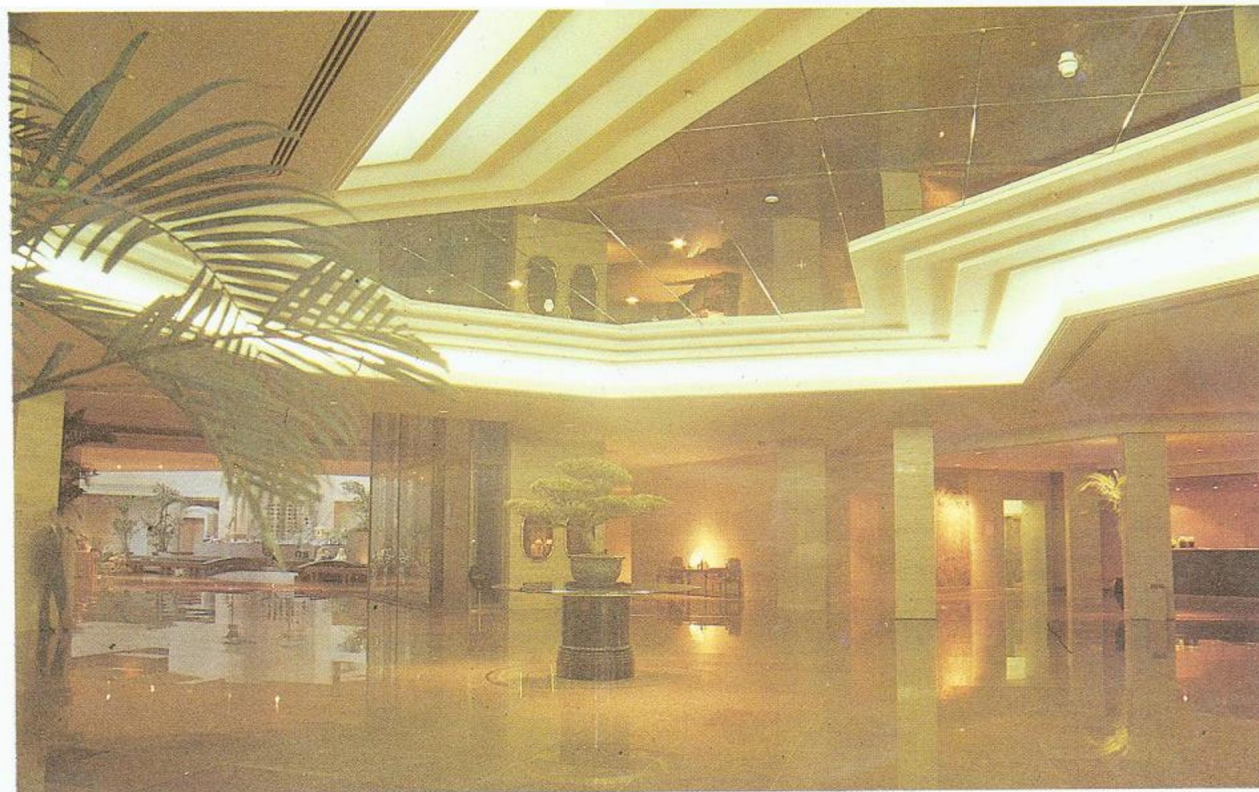
上海希尔顿大酒店前大厅的荧光灯带照明
