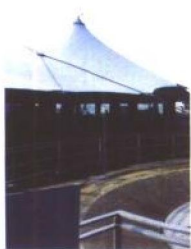
香港海防博物馆 建筑署
