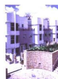
种植道 56 号 林周梁建筑师有限公司
