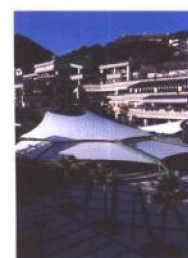
马坑村重建（第 1, 2 及 3 期） 房屋署建筑及发展处
