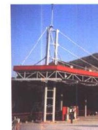
大屿山干线观景台—旅游设施 高和建筑设计事务所有限公司 Tourist Facilities, Lantau Link Observation Platform Quattros (P&A) Architects Ltd.
