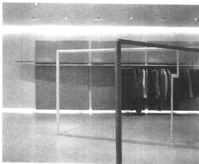
墙面的大型板材为木饰面铝板
