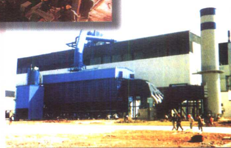
100t 电炉除尘系统（江阴兴澄钢铁有限公司）
