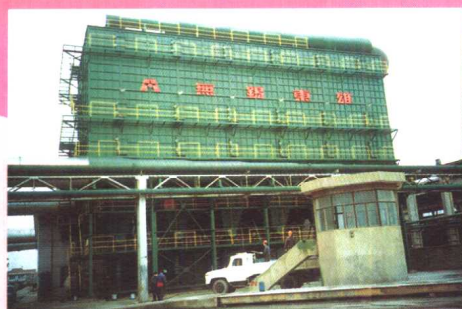
3 × 30t 电炉除尘系统（张家港钢铁集团公司）
