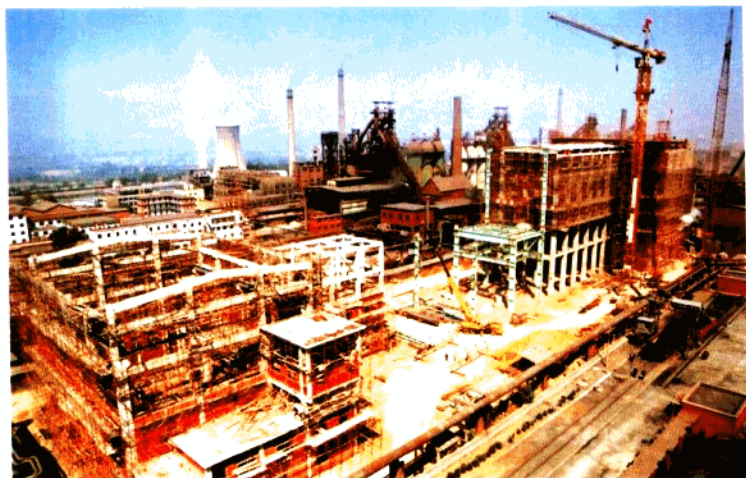
正在建设中的6号烧结机工程
