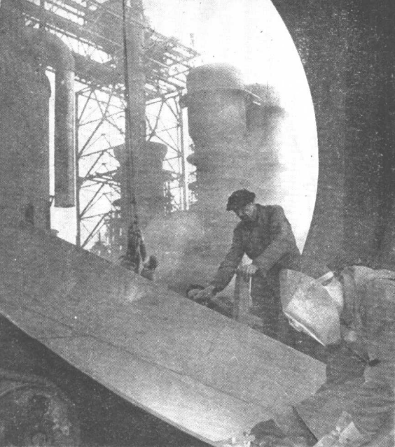
莫洛托夫金屬工厂的約瑟夫·哈盧帕工作隊在安裝熔鐵爐的排除器。
