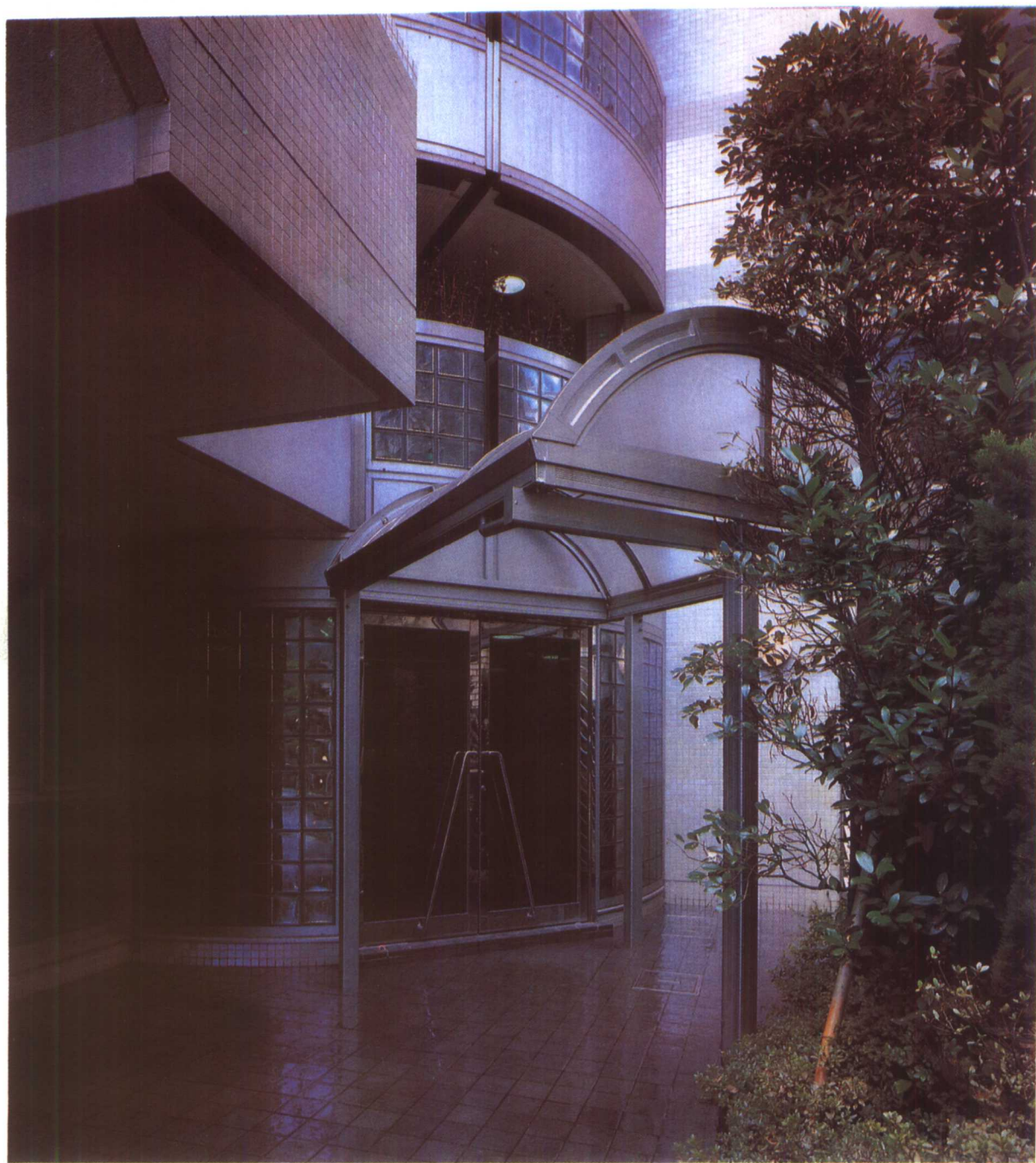
用拱型的玻璃顶棚作为入口的雨蓬,既透光,又防雨,亦颇具装饰性。
