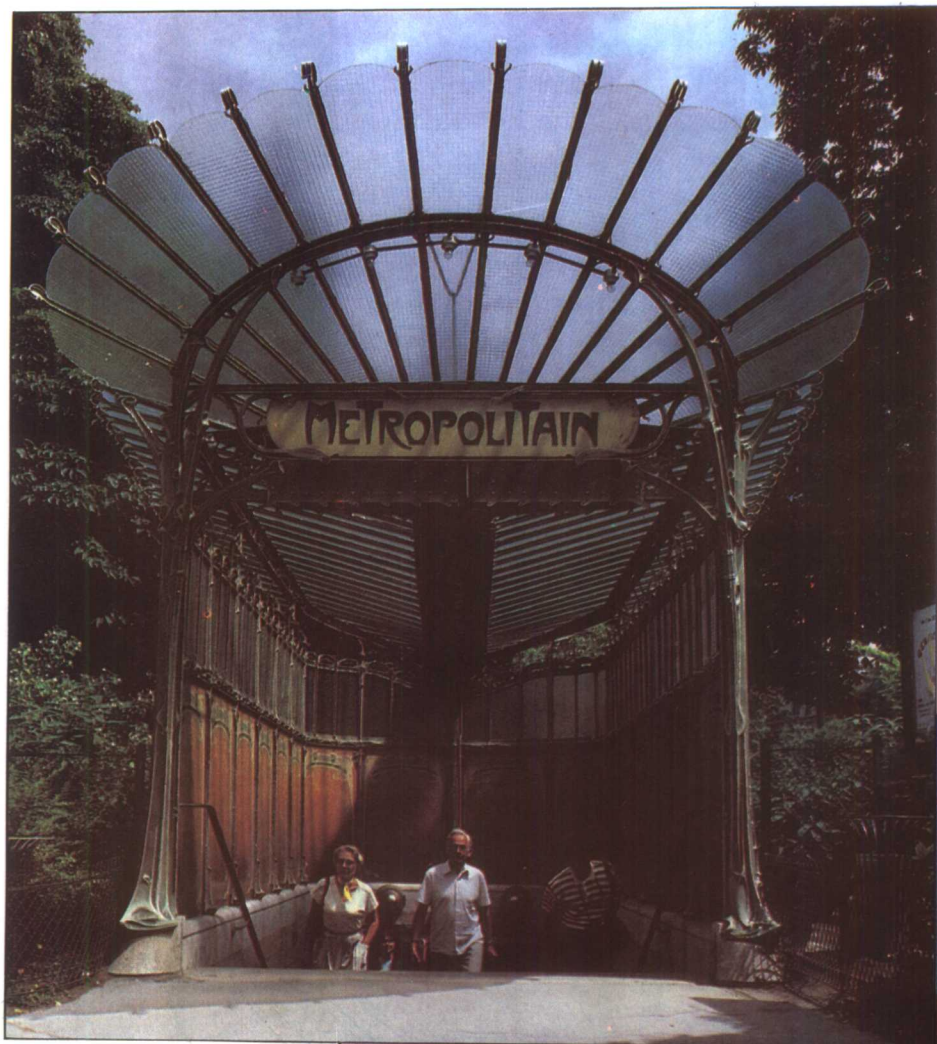
巴黎地铁入口。铸铁组合的有机自由形态，上翘的檐部，半透明的玻璃顶棚，开畅、轻巧，与街道环境极为协调。
