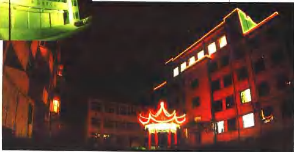
煤炭局生活区夜景
