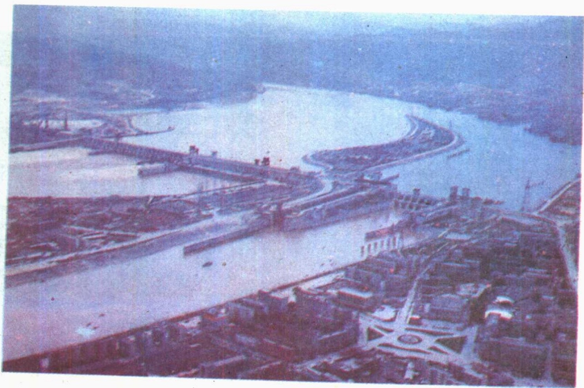
葛洲坝水利枢纽工程
