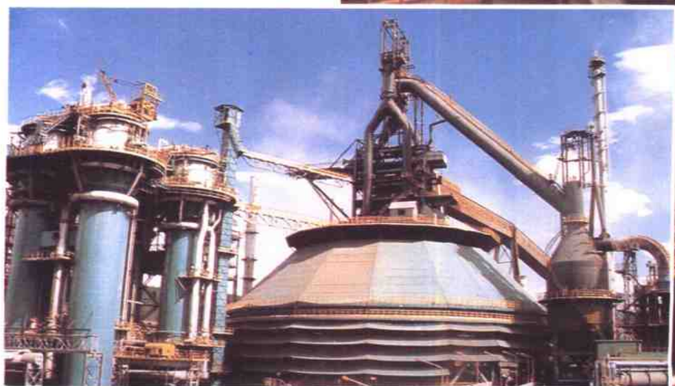
首钢二号高炉 1991年采用新技术大修改造后全貌
