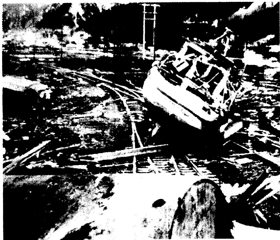
图 1—1 在 1964 年阿拉斯加大地震中，滔天海浪连续侵袭了阿拉斯加南部海岸。塔库·梅德渔船从西沃德海港被抛到铁路调车场。
