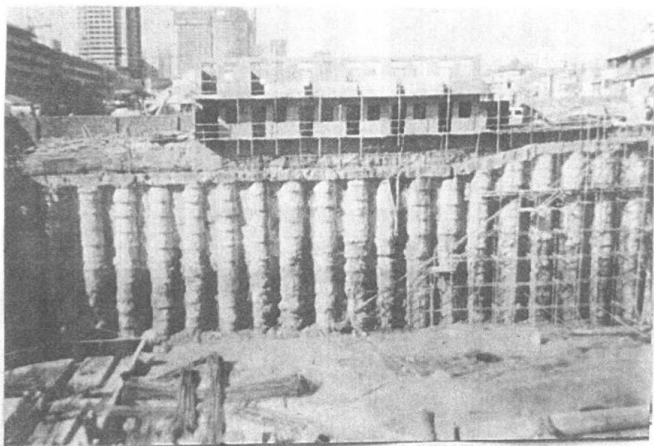
图 1-1 典型的传统方法：人工挖孔桩
