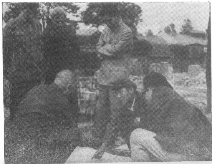
1983年 李代耕同志在云南漫湾水电站工地
